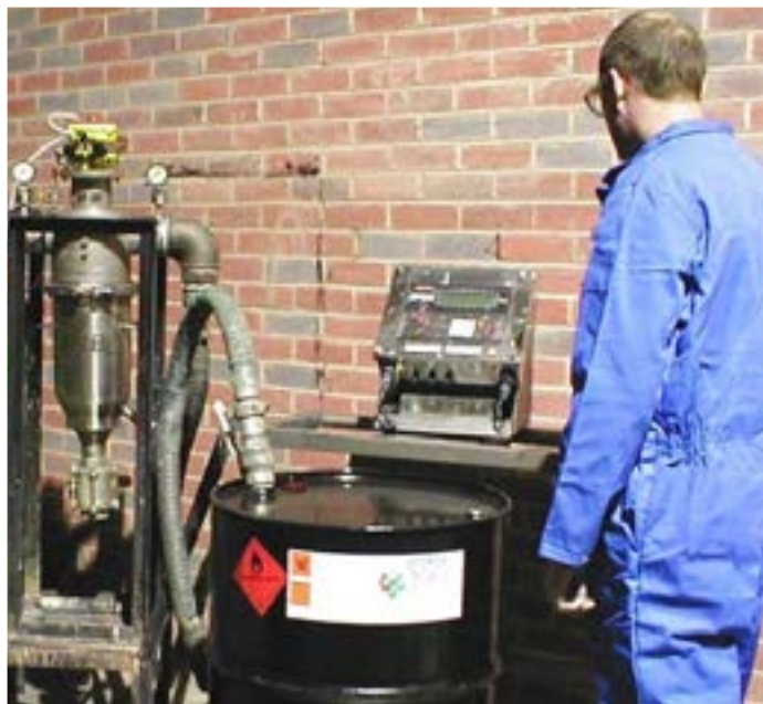
图1. Self-Cleaning Russell Eco Filter® 自清洁式过滤器安装在J. Stokes工厂
